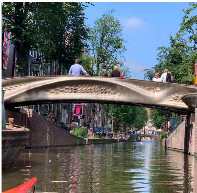
Stoorbrug in Amsterdam, een 3d-geprinte brug. Bron Wikipedia
